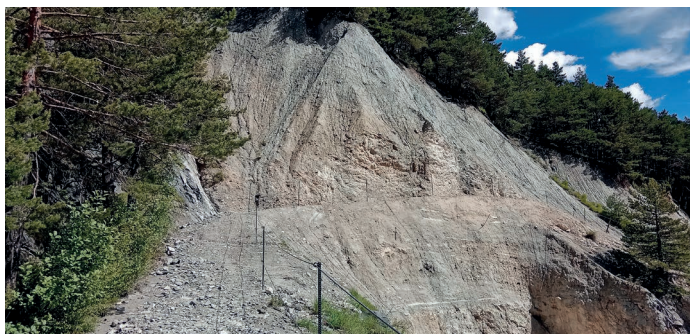
Travaux ravine blanche.
