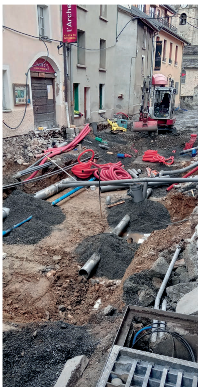
Travaux rue de l'église.
