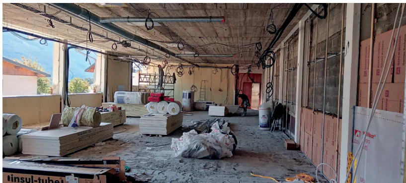
Travaux de la salle des fêtes.
